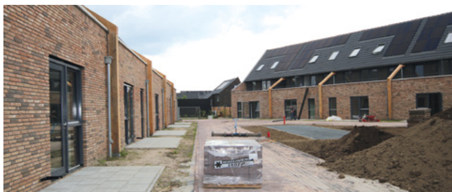
Aan de Kazemat worden beneden- en bovenwoningen gebouwd.
